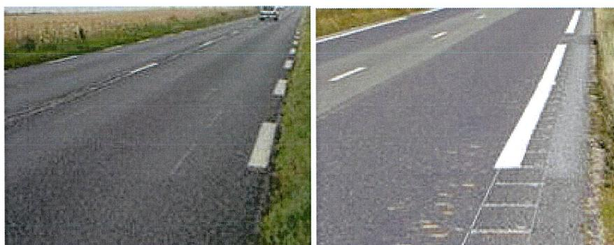
Figure 4. Illustration de la configuration du PT de la RD6014 avant (à gauche) et après (à droite) implantation des BAS de type creusée. Les BAS ont été implantées selon un pas de 80 cm. (Source photo, Le lez/Cerema-DTerNC/2013)
