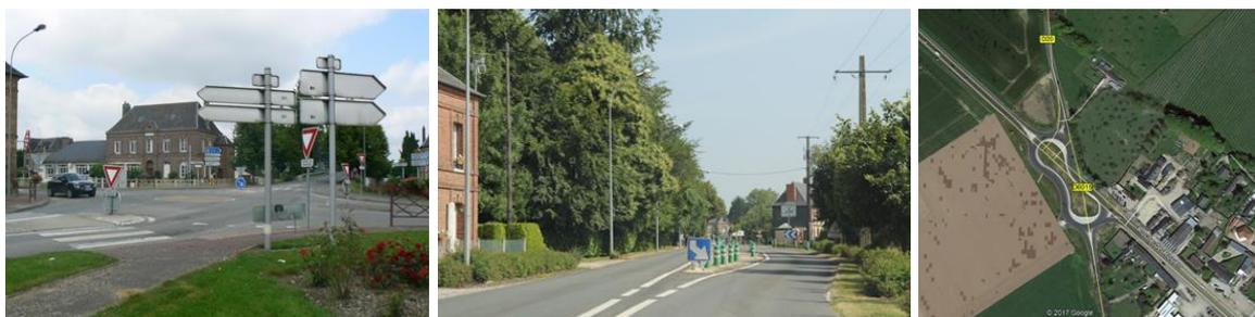
**Figure 17 : Aménagements évalués (giratoire, chicane et carrefour cacahuète)**
